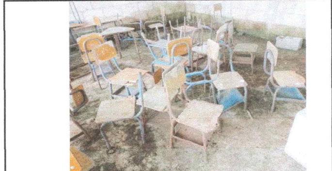
Foto 4: LA SUPERFICIE ES DE TIERRA: Se evidencia las dificultades que genera el piso de tierra en los escritorios y paredes.
