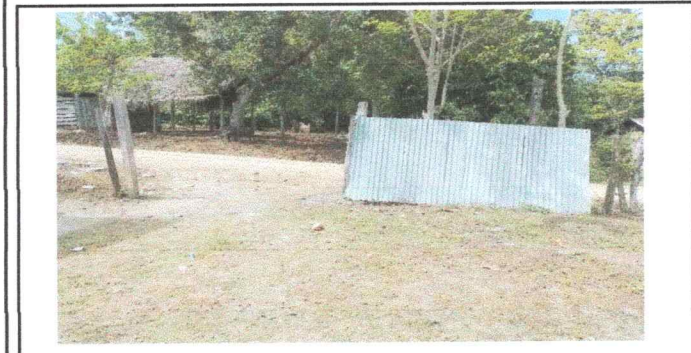
Foto 3: PORTO: SE EVIDENCIA EL DETERIORO DEL PORTÓN.
