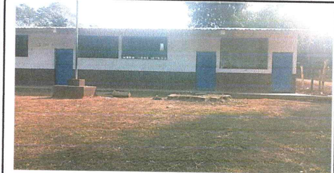
Foto7: PUERTAS EN MAL ESTADO (MÓDULO 1): SE NECESITA SUSTITUCIÓN DE LA PUERTAS.
